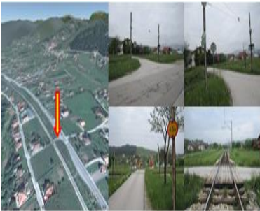
Slika 11. CPr Fazlića u Podlugovima, ukštanje lokalne ceste sa prugom
