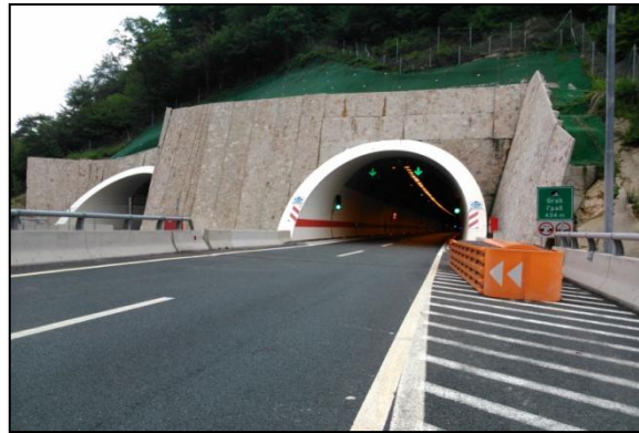
Slika 18. i 19. Ublaživač udara na ulazu u tunel Grab, projektovano i izvedeno stanje
