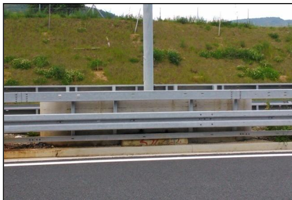
Slika 20, 21, 22, 23. Zaštita stupa rasvjete, zaštitna ograda SUPER-RAIL VZB H2-W3 Wn=0,9 m Projektovano i izvedeno stanje
