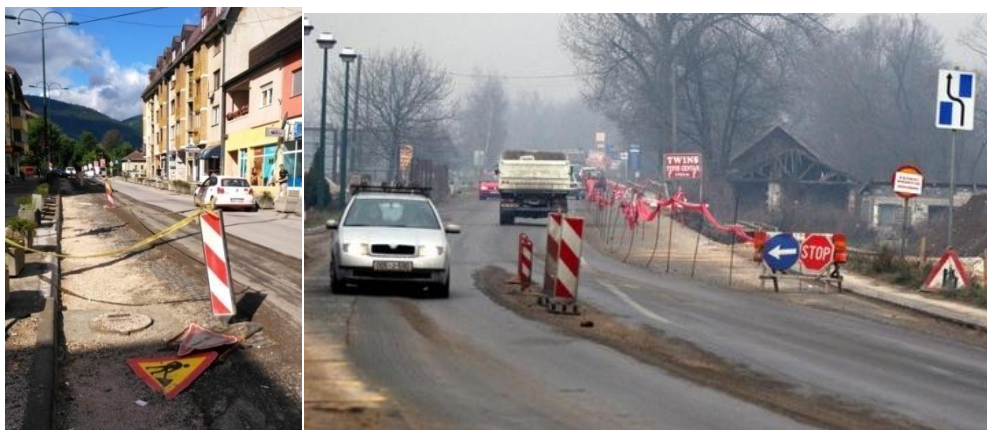
Slike 12. i 13. Saobraćajna signalizacija za vrijeme izvođenja radova
