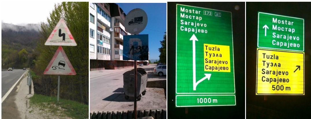
Slike 14., 15., 16. i 17. Primjer nekvalitetnih i kvalitetnih materijala za izradu saobraćajne signalizacije
