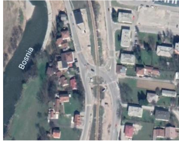
Slika 15. Izgled prijelaza 2019. poslije rekonstrukcije
