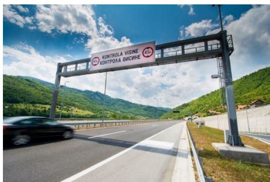
Slika 4. Portal sa laserima za mjerenje visine vozila i znakom izričite naredbe II-23 (Izvor: www.bstelecom.ba )
